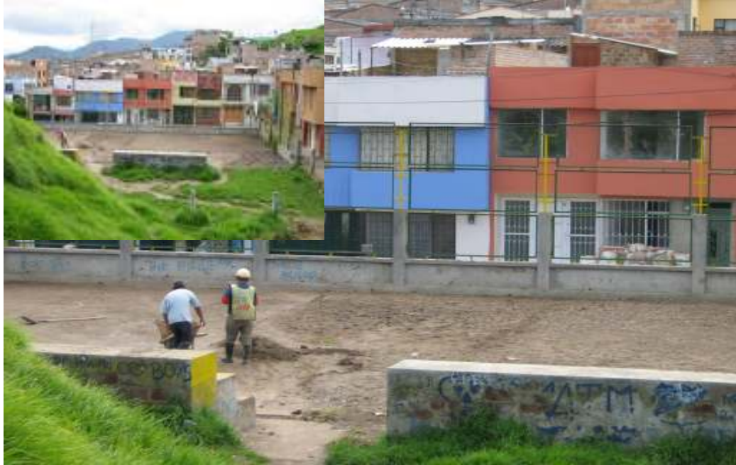
Figura No. 7. Zanja para desvío de aguas combinadas tramo carrera 13 entre calles 1a y 1b.
