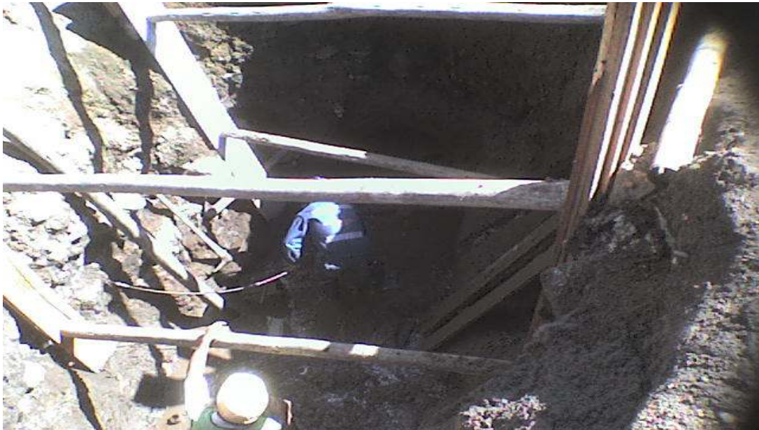
Figura No. 9. Entibado de zanja de excavación para protección de personal y de talud de excavación
