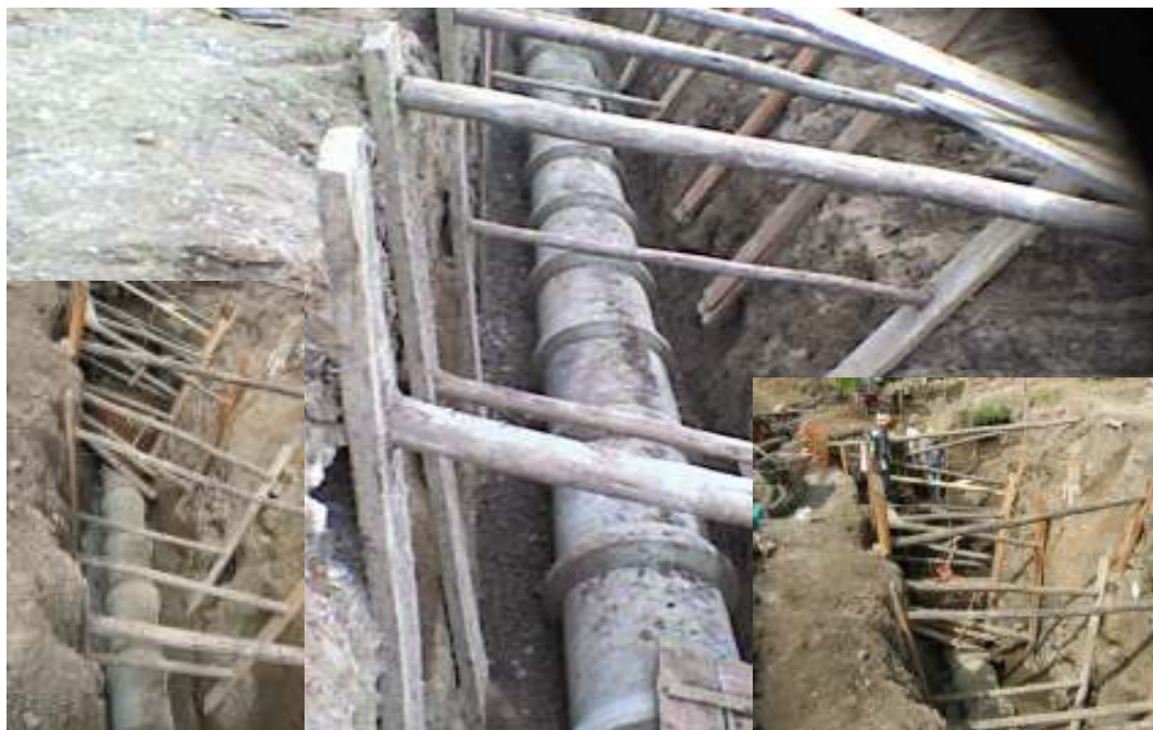
Figura No. 12. Atraque y relleno inicial sobre tubería de concreto diámetro= 24"
