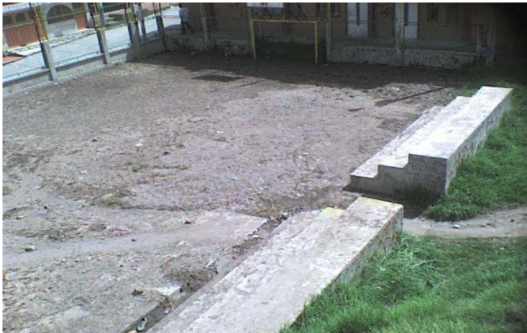
Figura No. 6. Retiro de material arrastrado por el agua en el polideportivo Barrio Caicedo Bajo
