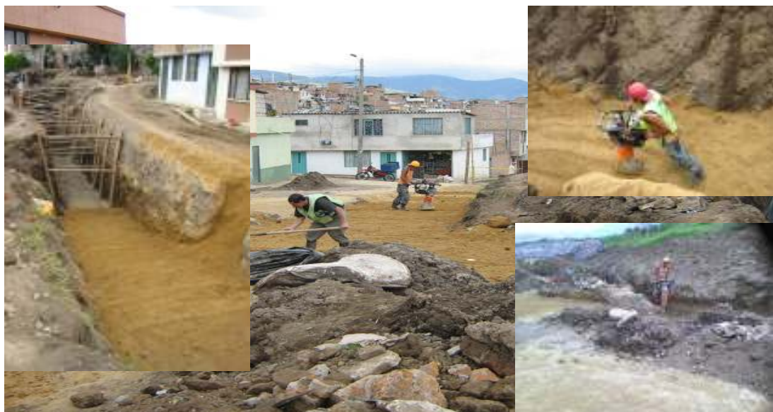
Figura No. 14. Relleno final con recebo compactado tramo cra 13 entre calles 1a y 1b
