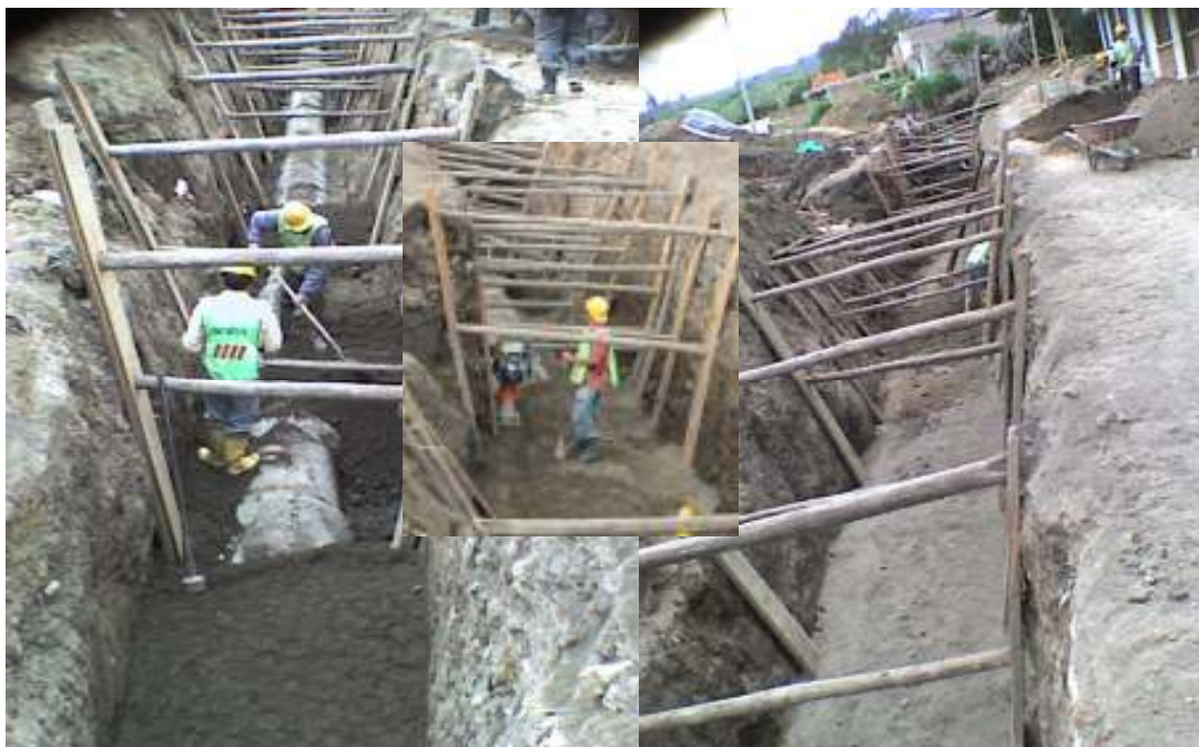
Figura No. 13. Relleno con material de préstamo tramo cra 13 entre calles 1a y 1b.
